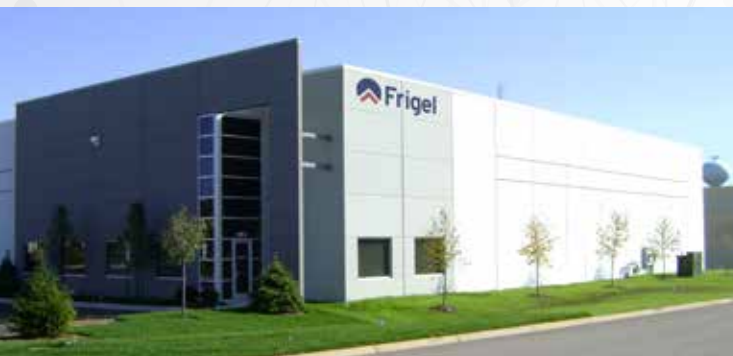
FRIGEL North America Fertigung, Service, Vertrieb Chicago - USA
